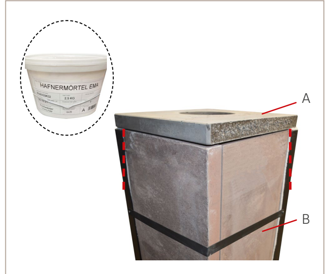
Abb. 30: Hafnermörtel in Fuge spachteln
